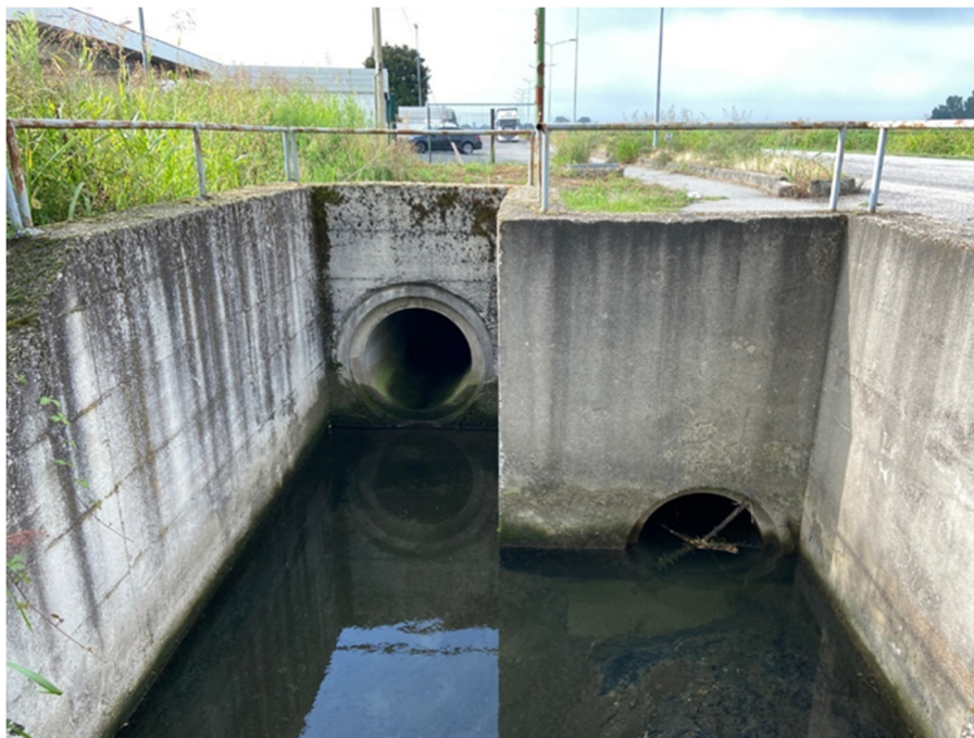
Figura 2.3: Manufatto di ingresso del tratto T1 dopo evento meteorico intenso
